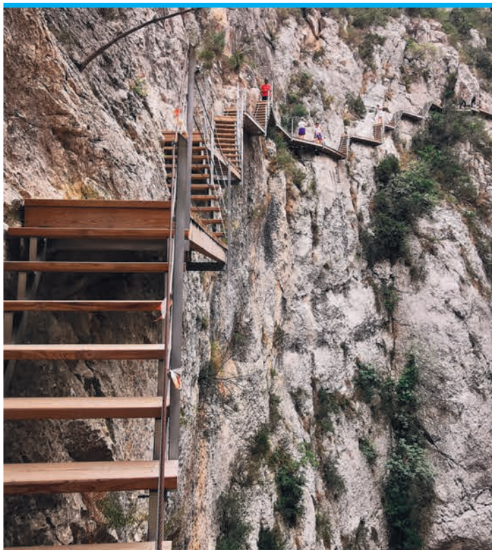
Der 370 Meter lange Steg klammert sich auf Stahlträgern spektakulär an die senkrechte Felswand.
