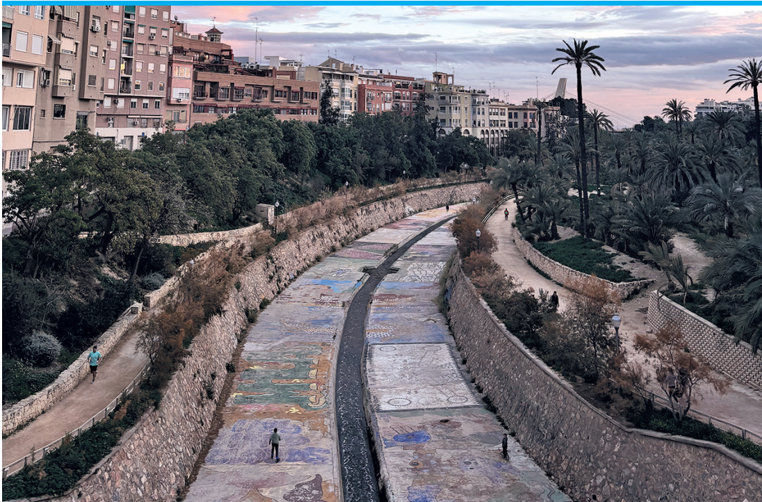
Das betonierte Flussbett des Vinalopó bietet sich für einen Spaziergang an.
