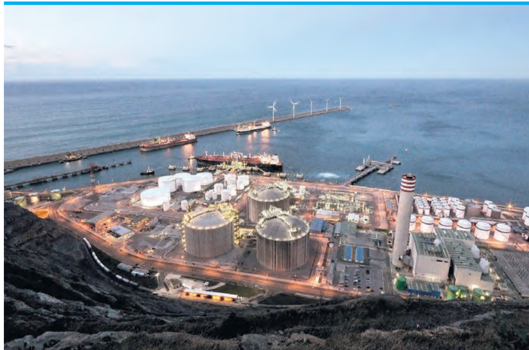
Gut aufgestellt bei Sprit, Kerosin und Gas: Die Anlagen von Enagás in Bilbao. Foto: Enagás
