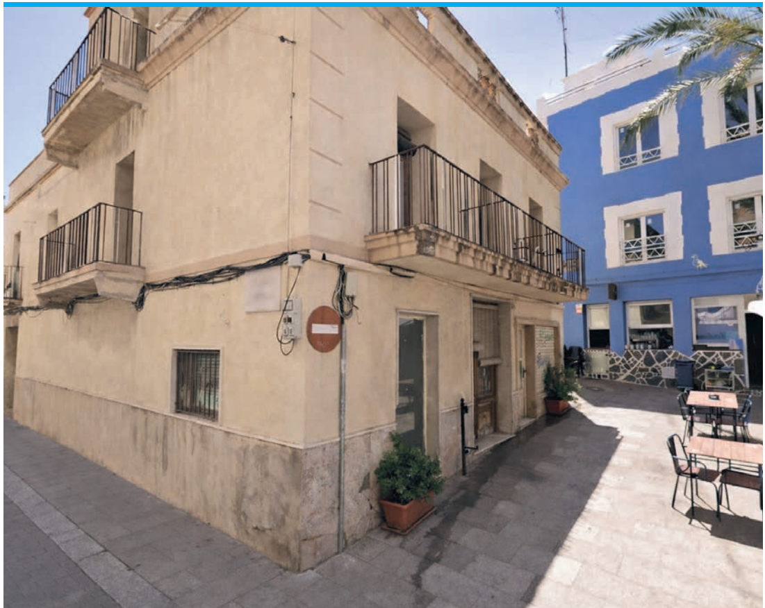
Die Casa Beltrán in der Altstadt von Calp wird zum Museu Fester umgebaut. Foto: O. Stahmann
