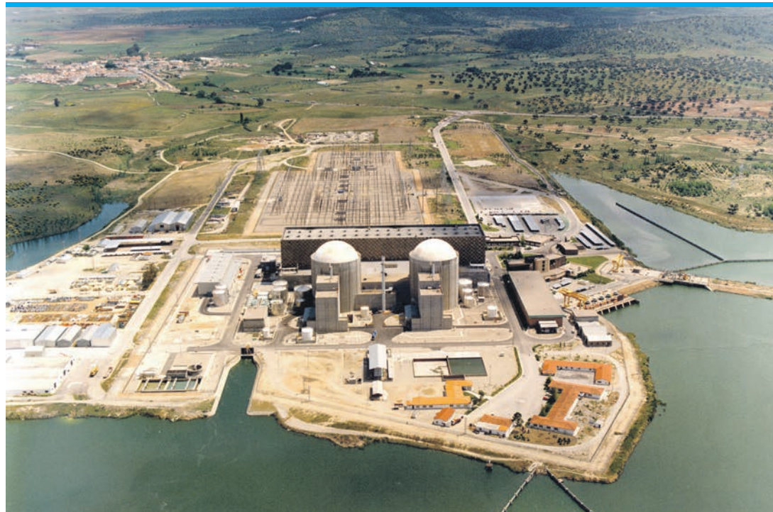
Strahlende Idylle: Das Kernkraftwerk Almaraz bei Cáceres, Extremadura.
